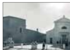
Panoramica della Chiesa e del piazzale
